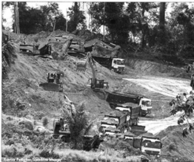
Le chantier hydroélectrique, démarré en 2012 et qui devrait se clôturer en 2015, est vivement critiqué par des scientifiques et des associations de défense de l'environnement. PHOTO DR
